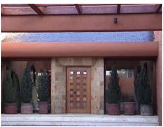
Acceso / Vivienda Fischer.
