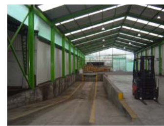
Vista interior Anden de Carga - Solfrut
